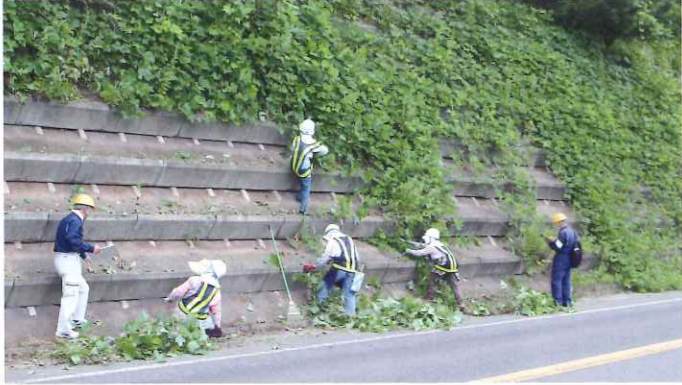
総合運動公園前町道 除草作業(安全パトロール実施中)
