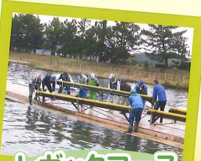
レガッタコース 設置・撤去業務
